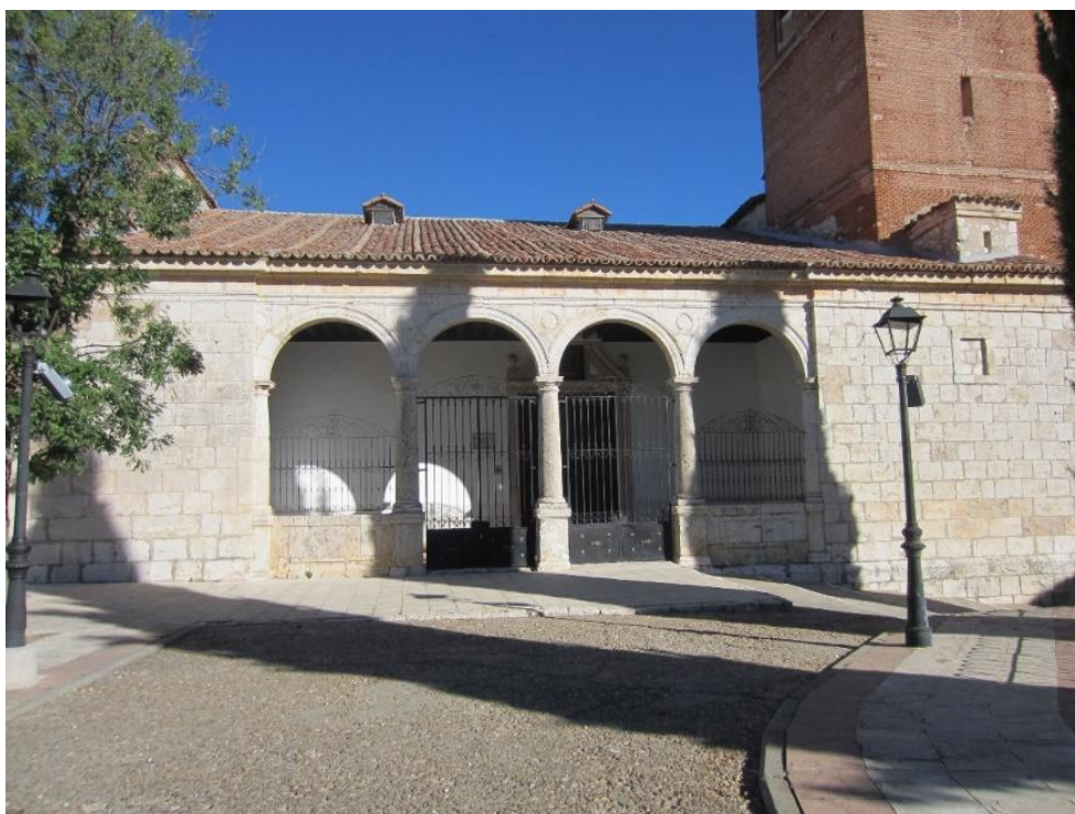
Fig. 2. Exterior del pórtico de la iglesia con las Capillas del Bautismo y del Cristo en los extremos, diseñado por Valentín de Ballesteros en 1611 y ejecutado por Pedro de San Martín y Francisco González entre 1611 y 1618.
